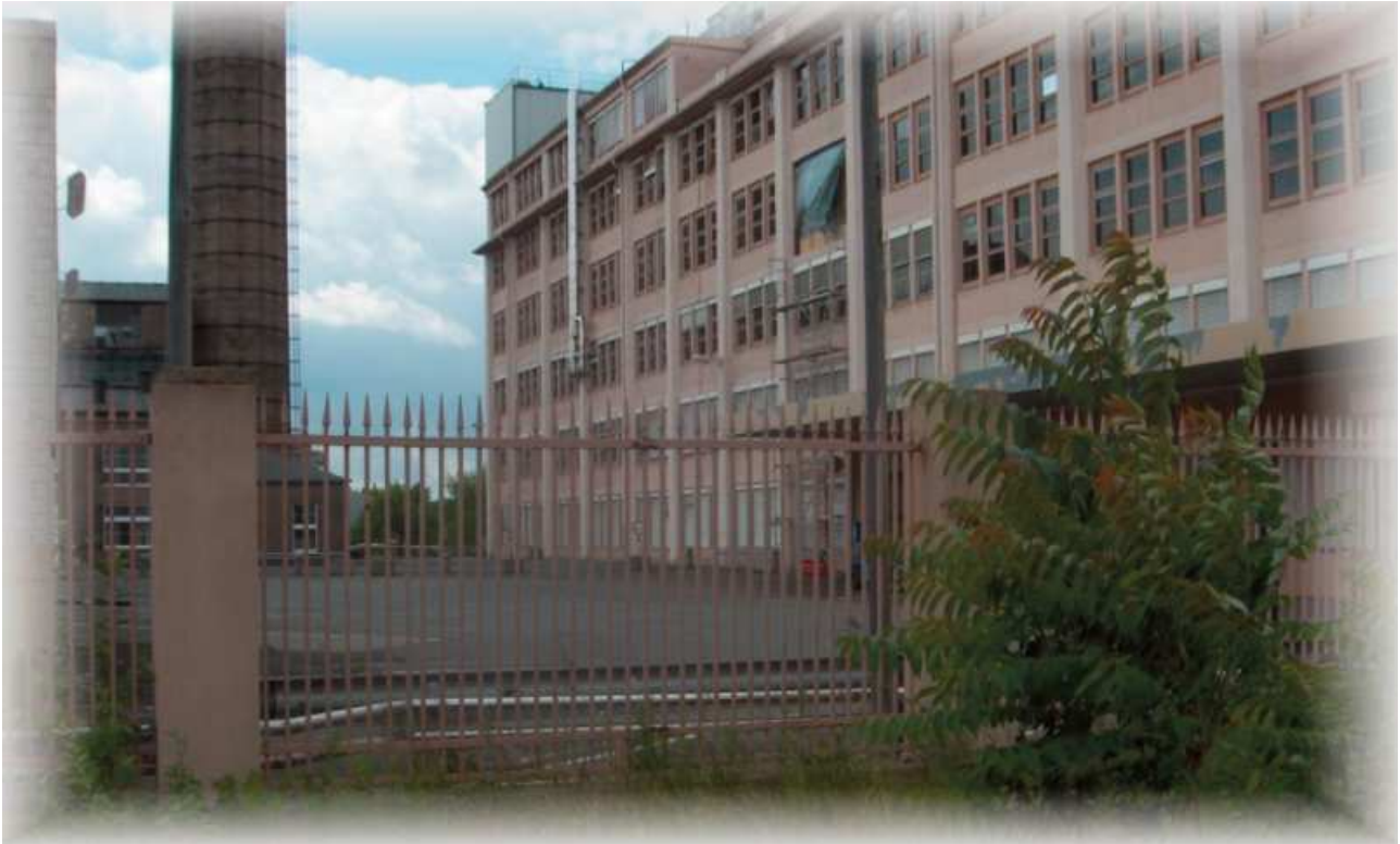
Blick von der Teilestraße auf das seit 2004 verwaiste Sarotti-Werk im Jahr 2008 (Foto: Horst Sack)
